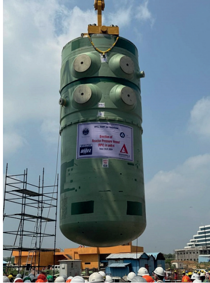
Рис. 2. Монтаж корпуса реактора методом open top
