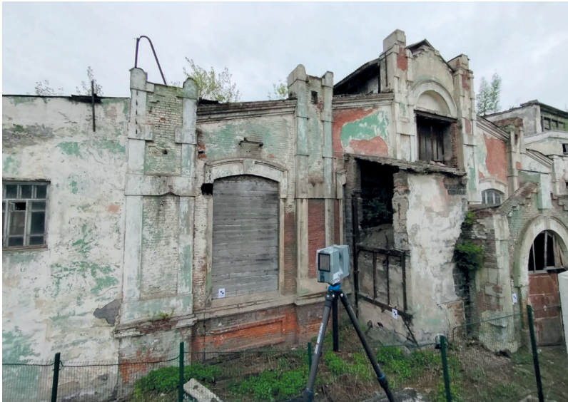
Рис. 4. Процесс лазерного сканирования здания
