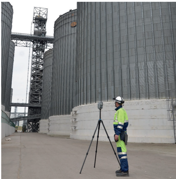
Рис. 7. Процесс сканирования зернового терминального комплекса
